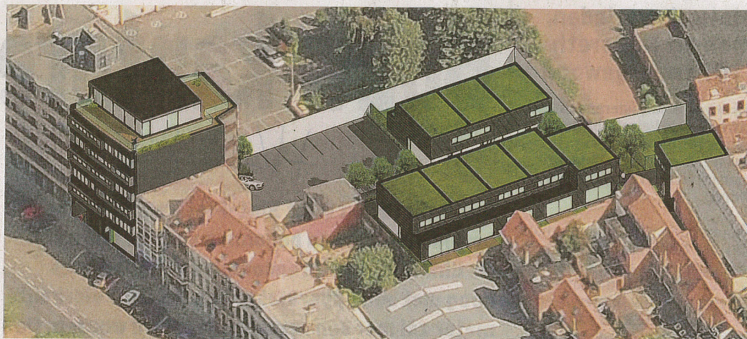
Zo zal het nieuwe bouwblok eruit zien tegen eind 2012. Beeld Upgrade Estate
